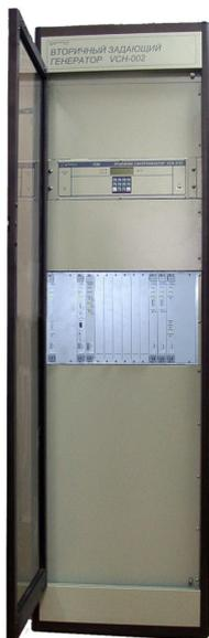
Вторичный задающий генератор (ВЗГ) предназначен для работы в цифровой сети связи в качестве аппаратуры синхронизации второго уровня иерархии. Его задачей является отслеживание по фазе одного или нескольких синхросигналов, поступающих по сети от синхронизирующей аппаратуры высшего или равнозначного уровня иерархии. ВЗГ производит оценку качества этих сигналов, их фильтрацию и размножение восстановленных тактовых последовательностей с частотой 2048 кГц на входы оборудования узла связи.
